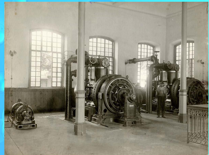
Первая в мире промышленная электростанция в Новороссийске
